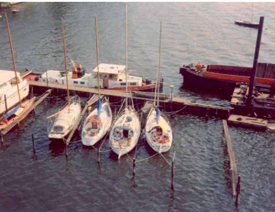
Bau des Mastenkrans 1983
